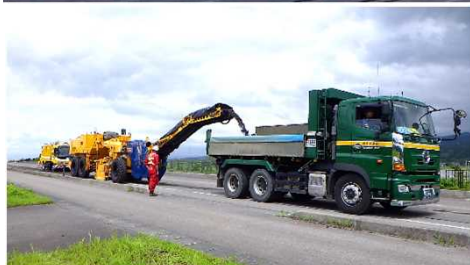
劣化したアスファルトを路面切削機で削っている様子
