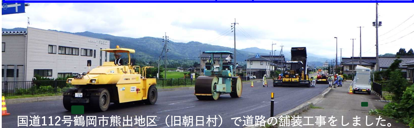
トラックからアスファルトフィニッシャーにアスファルトを移し、敷きならしている様子
