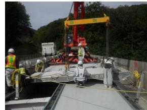
施工状況(梵字川橋)
