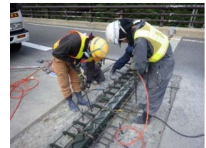
施工状況(大網川橋)
