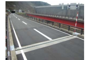
施工完了後(大網川橋)
