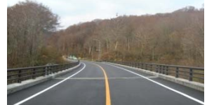
施工完了後(梵字川橋)
