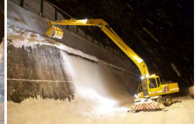
擁壁上部などの高所の除雪
