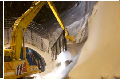
擁壁上部などの高所の除雪
