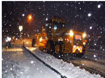
装着確認当日は積雪となり、 除雪車も出動しました。
