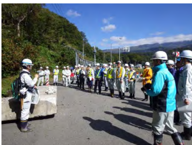
実際の撤去した床版を 使って状態の確認
