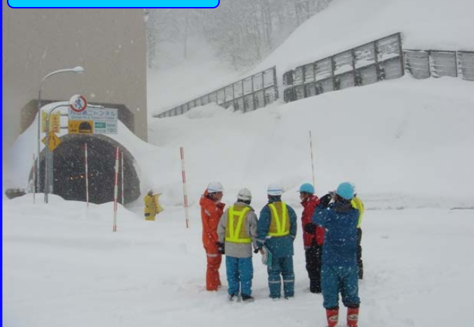
雪崩点検実施状況
