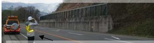
落石の危険性がないかなど斜面を確認してます
