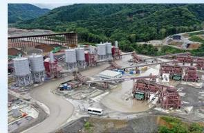
写真-3 CSG製造設備（成瀬ダム）
