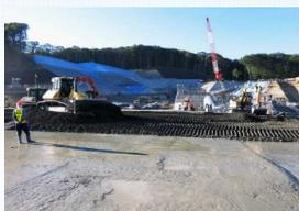
写真-6 CSG敷均し状況（ブルドーザ）
