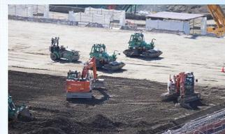
写真-7 CSG転圧状況（振動ローラ）
