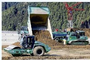
写真-5 CSG荷卸し状況（ダンプトラック）
