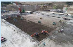
写真-4 CSG打設状況（全景）
