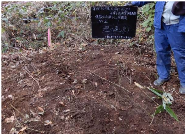
▲ダムサイトでの試掘調査後の復旧状況(H30.10.26)
