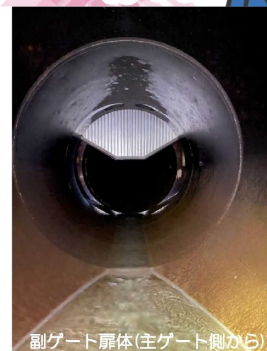
副ゲート扉体(主ゲート側から)
