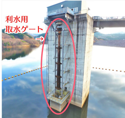
※赤線 利水用取水ゲートから 水が流れていく道筋 取水塔 管理庁舎 管理用 発電機室 放流 ゲート室
