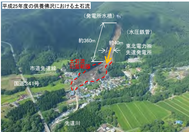
平成25年度の供養佛況における土石流
