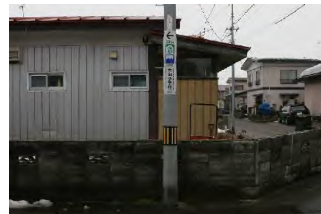
電柱に設置した例（大仙市）
