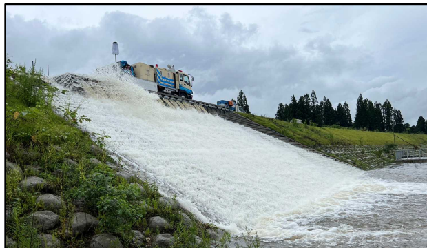
令和5年7月19日 西仙北・大佐沢樋門
