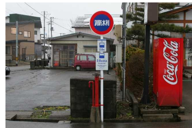
標識に設置した例（大仙市）
