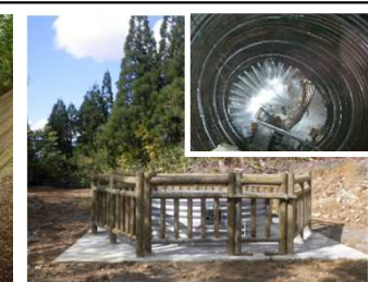
地すべり防止工
