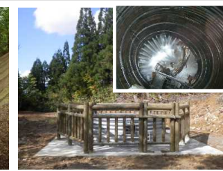
地すべり防止工
