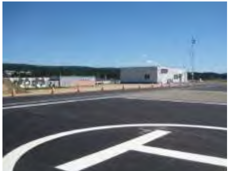
涌谷地区河川防災ステーション
