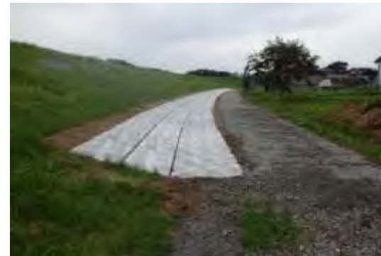
堤防裏法尻の補強
