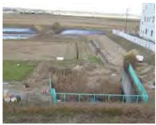
志田谷地排水樋門の法裏部 排水敷高の工夫等により、排水能力向上を図る
