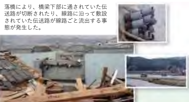
気仙大橋 (国道45号) が流出し、橋梁下部に設置されていた中継伝送路が切断 (岩手県陸前高田市)
