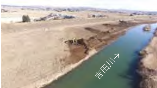
河道掘削イメージ
