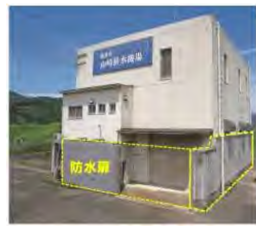
排水機場の非浸水化事例 山崎排水機場（牛津川（佐賀県））では、コンクリートによる防水壁を設けた。
