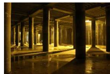
貯留施設の整備
