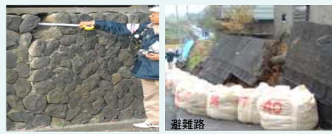
擁壁の危険度調査
