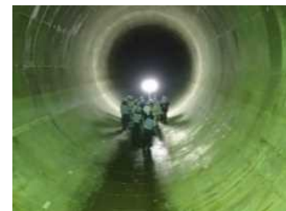
雨水貯留管の整備
