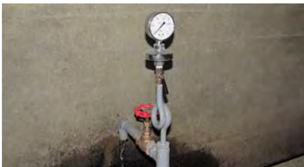
漏水観測(圧力計)
