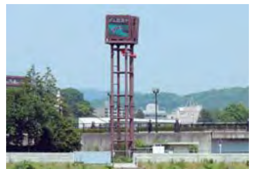
大型電光表示板
