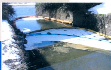
油の回収作業の様子
