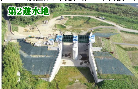
長島水門(建設中) 6位
