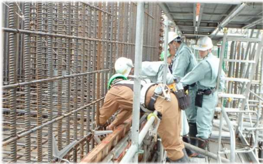
鉄筋組立て検査立会いの様子
