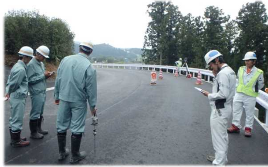
自動追尾トータルステーションによる測量の様子
