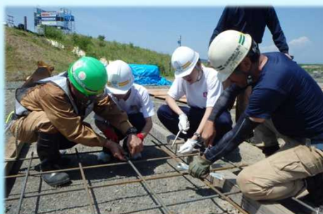
工事現場を見学し、鉄筋組立をしました。
