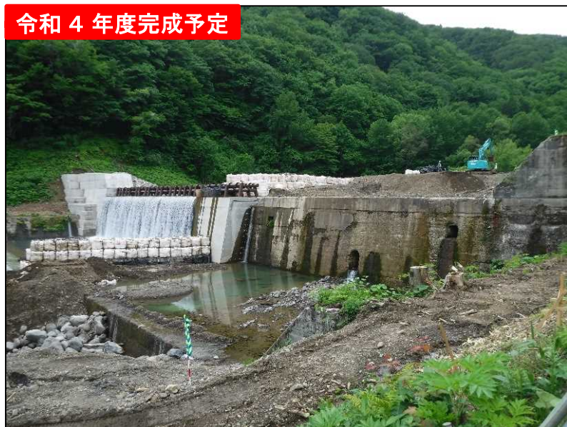
▲竜川第2砂防堰堤(R4.6時点)
