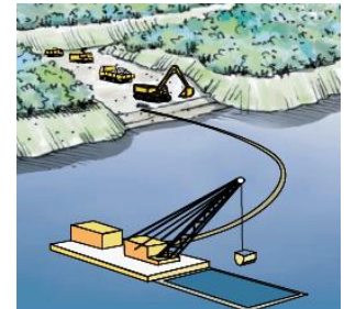
浚渫(取り除く)
