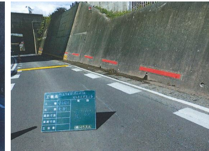
壁面浸水深表示
