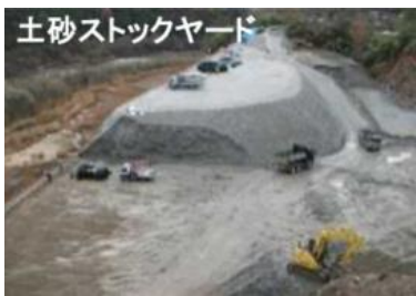
ストックヤード (土砂有効利用)
