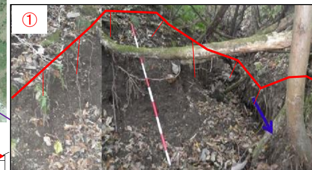
溪岸浸食状況
