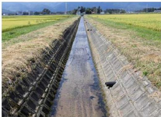
→ 基盤整備時に整備された排水路形態
