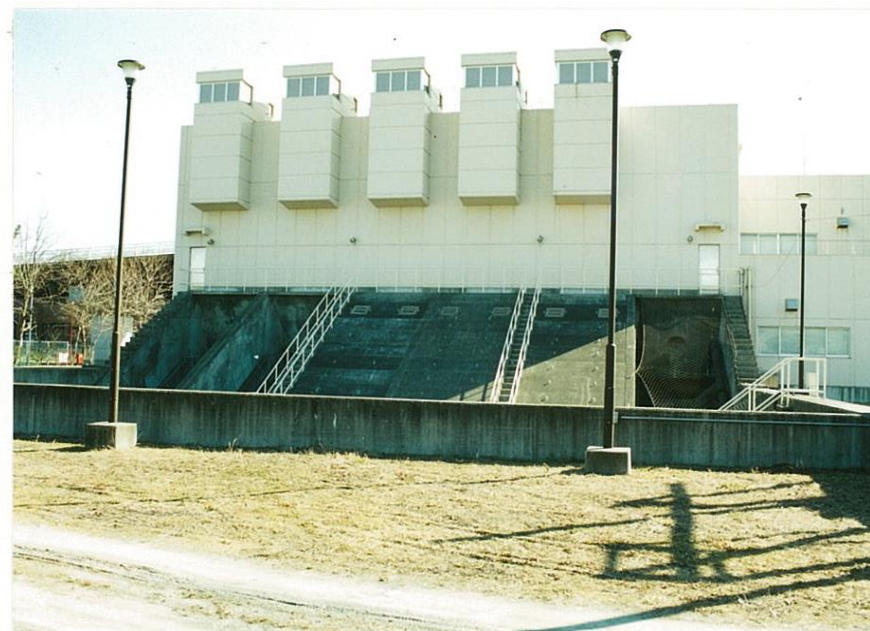
(事例) 防水扉等により耐水化された湊雨水排水ポンプ場 (宮城県石巻市川口町)
