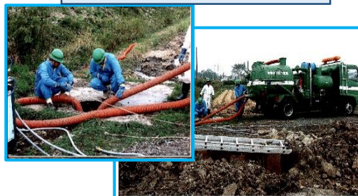
山の神都市下水路浚渫作業
