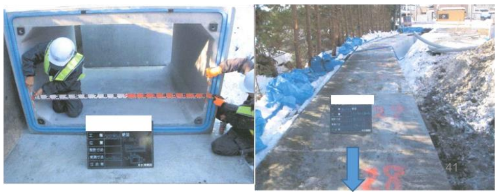
排水路の整備(1800×1100)
