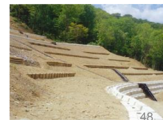
【治山：山腹工(雫石町)】
