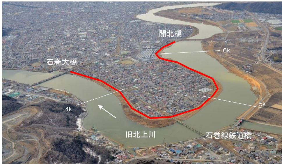
袋谷地地区(石巻市大橋 地先)、水押地区(石巻市水押 地先) 96
