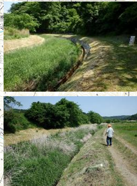
土砂堆積状況
