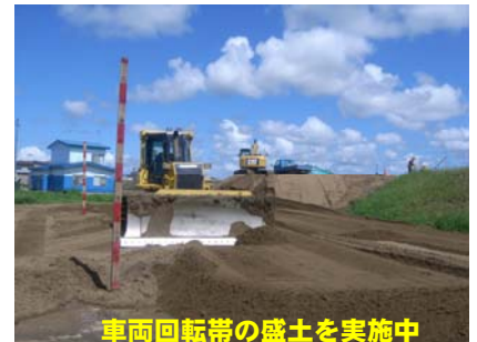
車両回転帯の盛土を実施中
