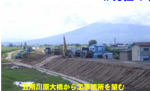
元の堤防の高さまで盛土が概成
