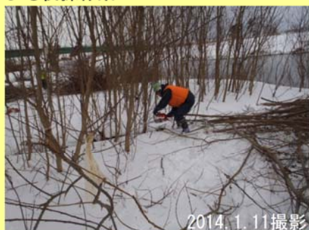
チェーンソーによる伐採作業
