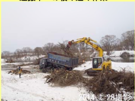
運搬車への積み込み作業
