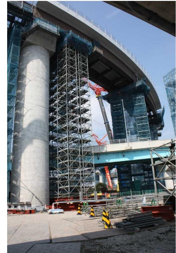
【参考】昇降設備と幅木付作業床を内蔵した折り畳み式ベント
