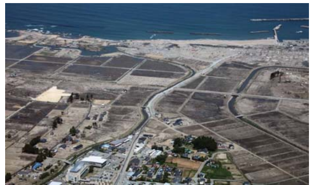
被災状況(新地町)平成23年5月25日撮影 出典:国土地理院HP
