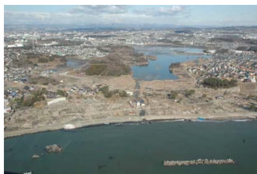
被災状況(七ヶ浜町)平成23年3月27日撮影 七ヶ浜町提供(自衛隊撮影)
