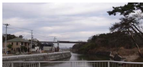
搬土用のベルトコンベア(野蒜駅前より撮影)
