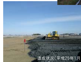
造成状況(平成25年1月)
