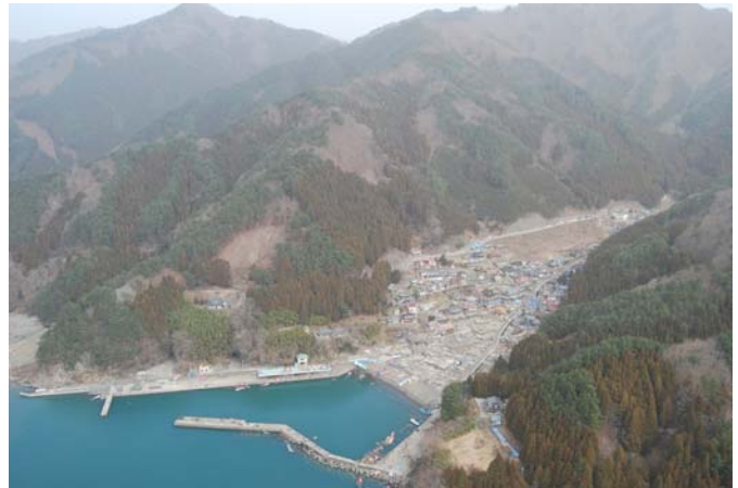
被災状況(釜石市花露辺地区)平成23年3月20日撮影
