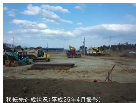
移転先造成状況(平成25年4月撮影)
