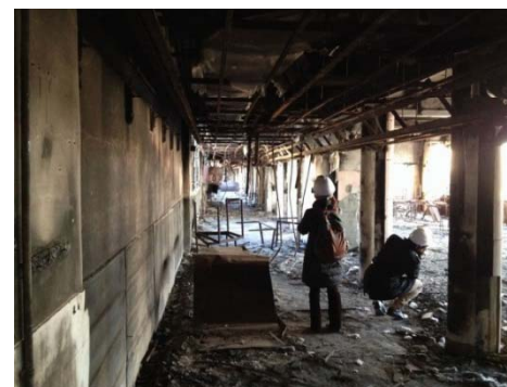
▲ 旧門脇小学校校舎内部(3階東側)
