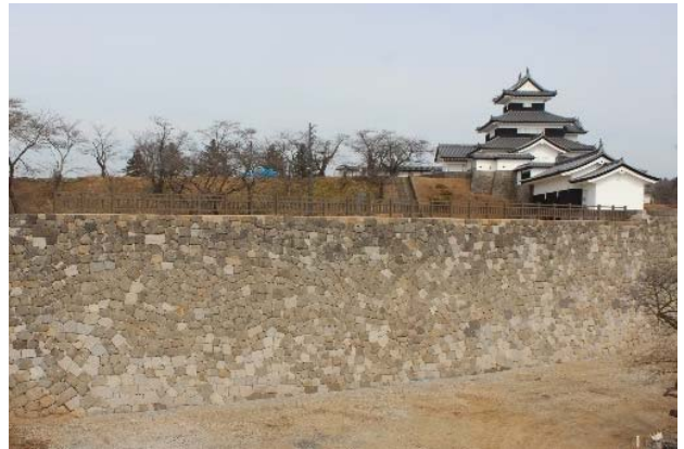
復旧後の小峰城
