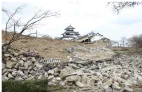
震災により崩落した石垣（本丸南面）
