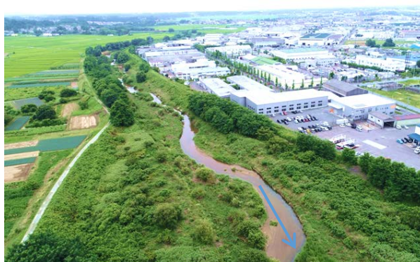
写真6 ドローンによる状況調査
