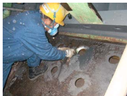
写.9 トラフ底面部補修状況
