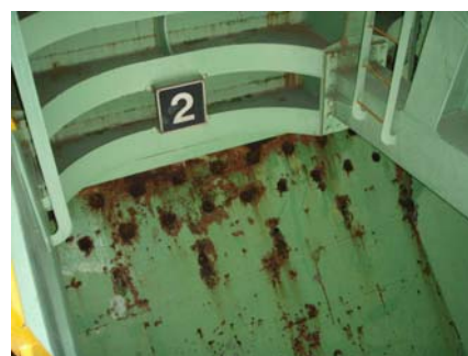
写.2 放流水を受ける整流部
