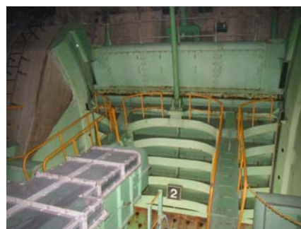
写.1 コンジットゲート全景
