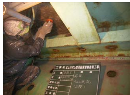
写.6 2種ケレンの実施状況（扉体下部）
