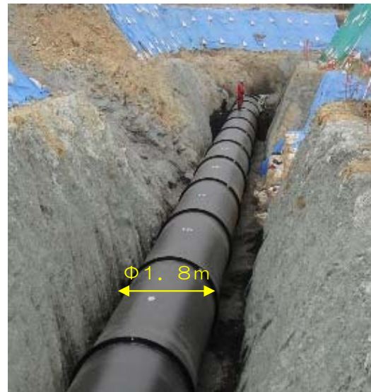
写真－1 埋設区間の管設置状況
