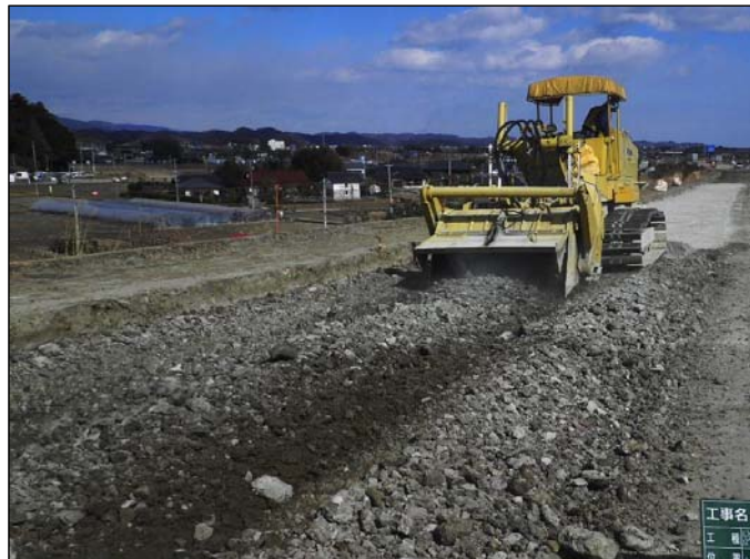
▲泥土のセメント改良状況
