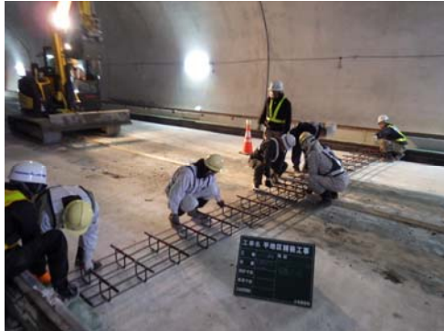
横目地設置状況
