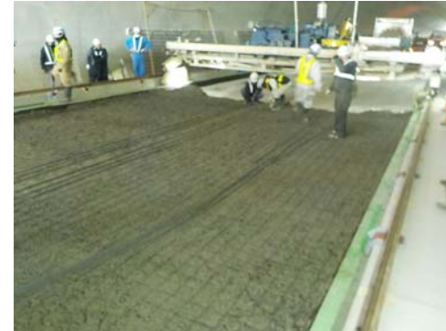
配筋完了状況（横目地無し）
