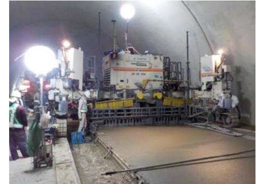
舗設状況（成形機による締固め）
