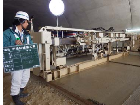
舗設状況（コンクリートフィニッシャによる締固め）
