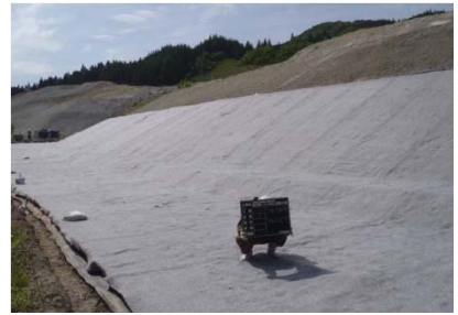
遮水シート設置状況 (他事例より)
