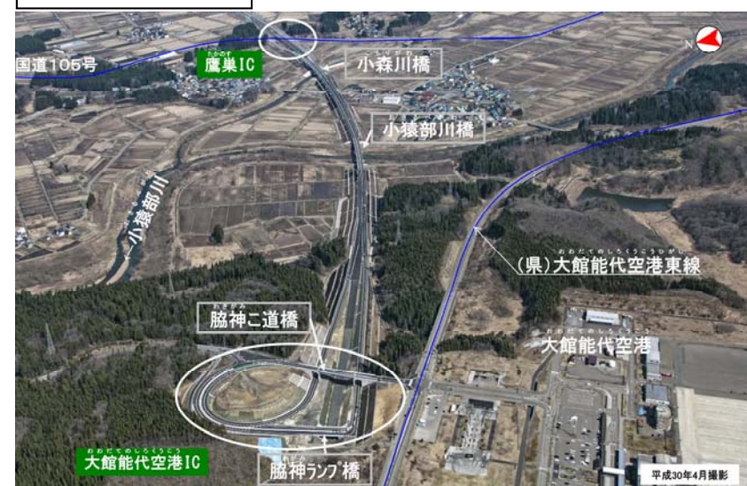
② 開通区間の全景
