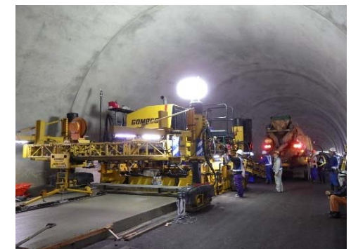
舗設状況 (成形機による締固め)
