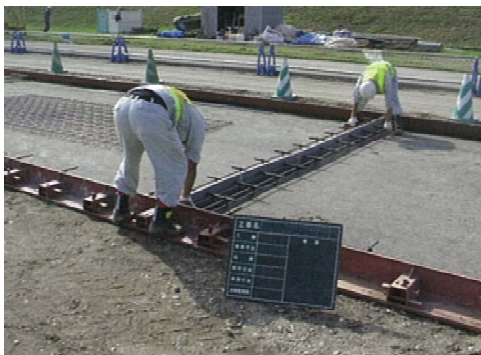
横目地設置状況
