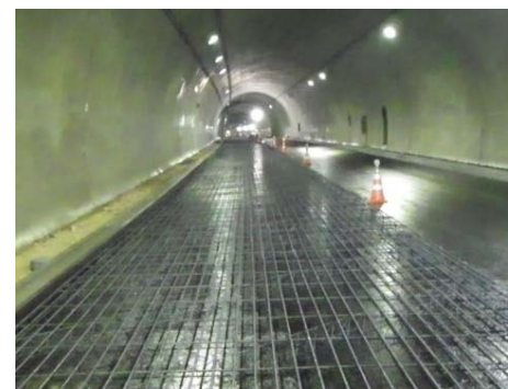
配筋完了状況 (横目地無し)
