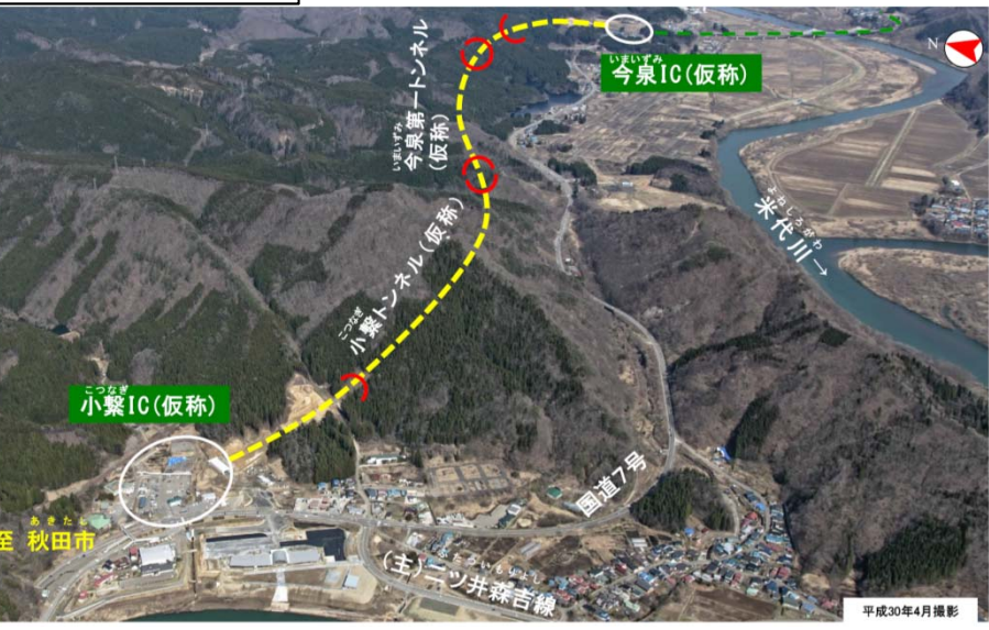
① 起点側からの全景
