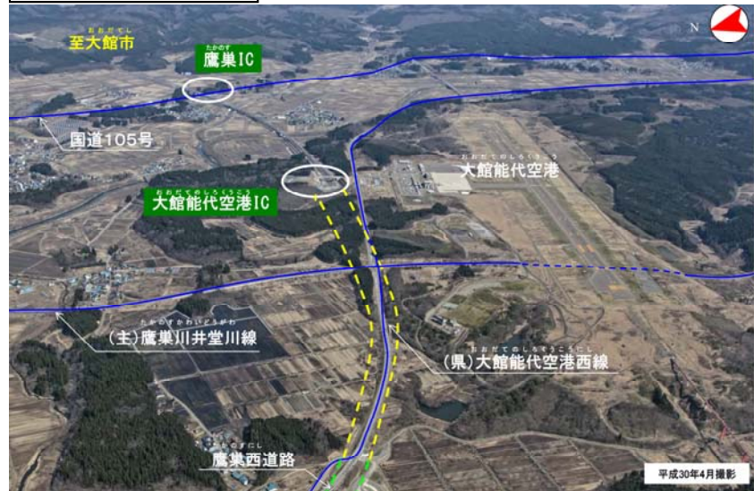
① 起点側からの全景
