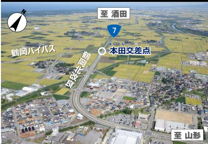
② 鶴岡駅方面から見た鶴岡北改良 (H27.9)
