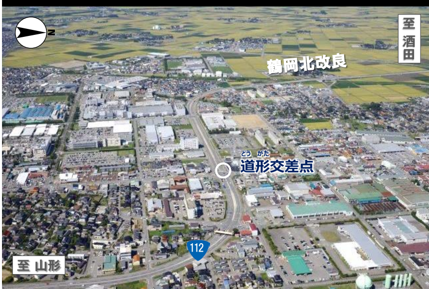
① 起点側(山形方面)から見た鶴岡北改良 (H27.9)
