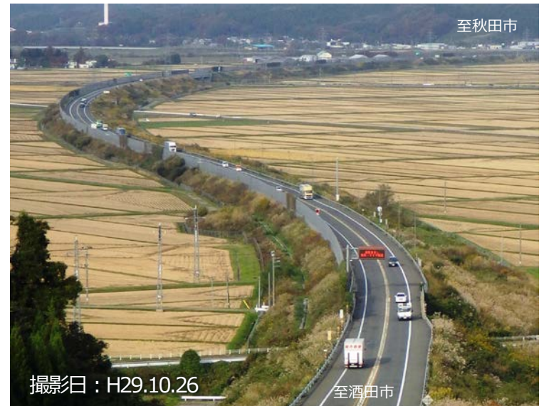
【写真③】開通後 (仁賀保本荘道路本線)
