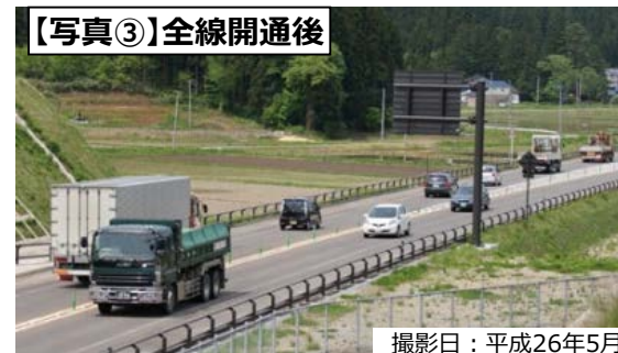
角館バイパス: H25.3開通区間
