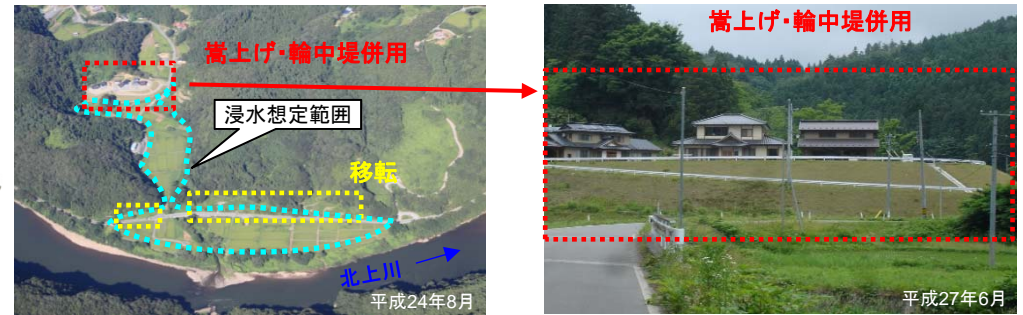
輪中堤・嵩上げ併用等の整備概要写真 (番台地区)
