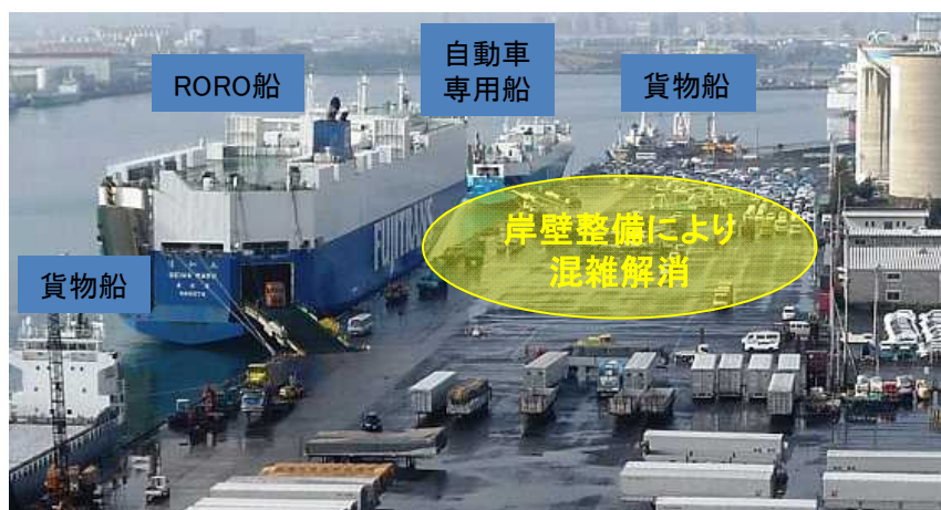
完成自動車とバラ積み貨物を取り扱う中野埠頭の荷役状況
