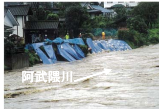
河岸崩壊の拡大を防ぐシート張り（福島県福島市）
