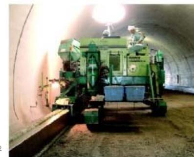
▲機械による側溝の現場打ちの状況
