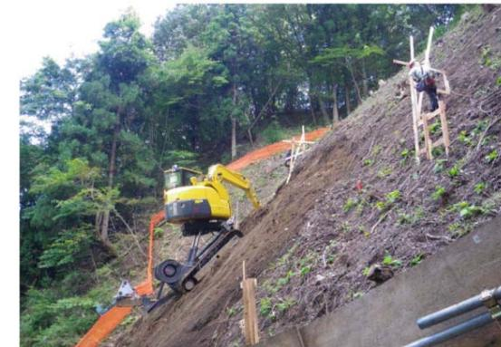
ロッククライミングマシンによる掘削作業状況
