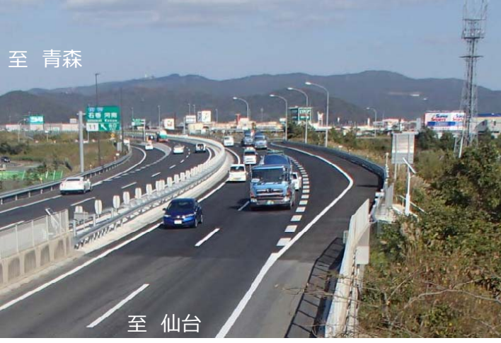
▼矢本石巻道路の開通後の状況
