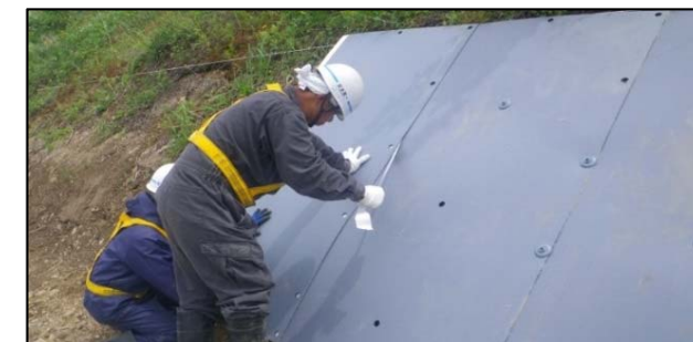
▲ポリプロピレン製中空積層板設置状況(イメージ)
