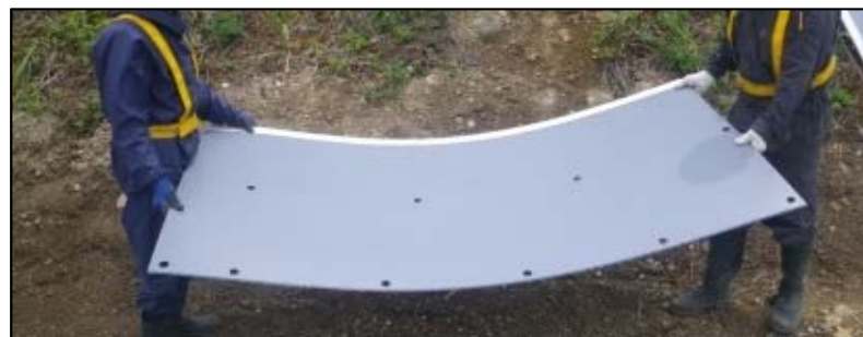
▲ポリプロピレン製中空積層板設置状況(イメージ)
