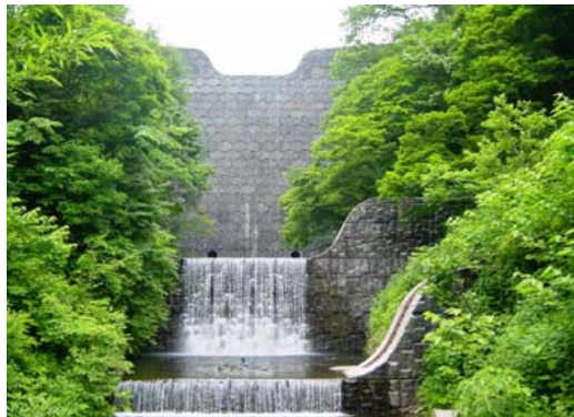
化粧型枠により修景した砂防堰堤 (松沢川砂防堰堤)
