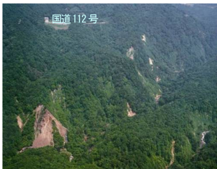
梵字川右岸小沢上流域の荒廃状況 (上方に見えるのは国道112号) ほんじがわ
