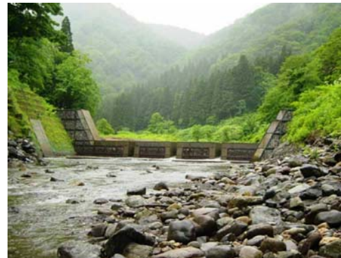
溪流の連続性に配慮した砂防堰堤 (西大鳥川第1砂防堰堤)
