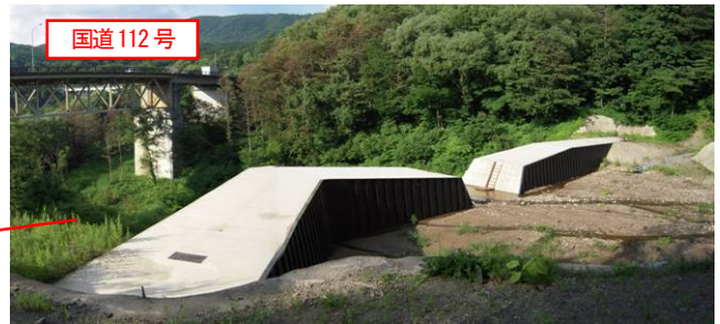
国道 112 号直上流の堰堤を優先的に整備（岩菅沢第一砂防堰堤）
