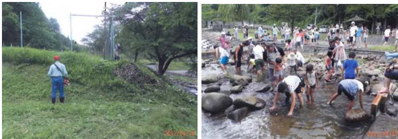
戸沢川砂防堰堤と周辺整備状況
