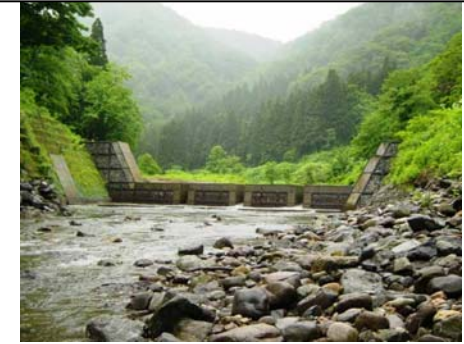
溪流の連続性に配慮した砂防堰堤 (西大鳥川第1砂防堰堤)
