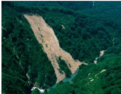
八紘沢流域の溪岸崩壊状況 はっこうざわ
