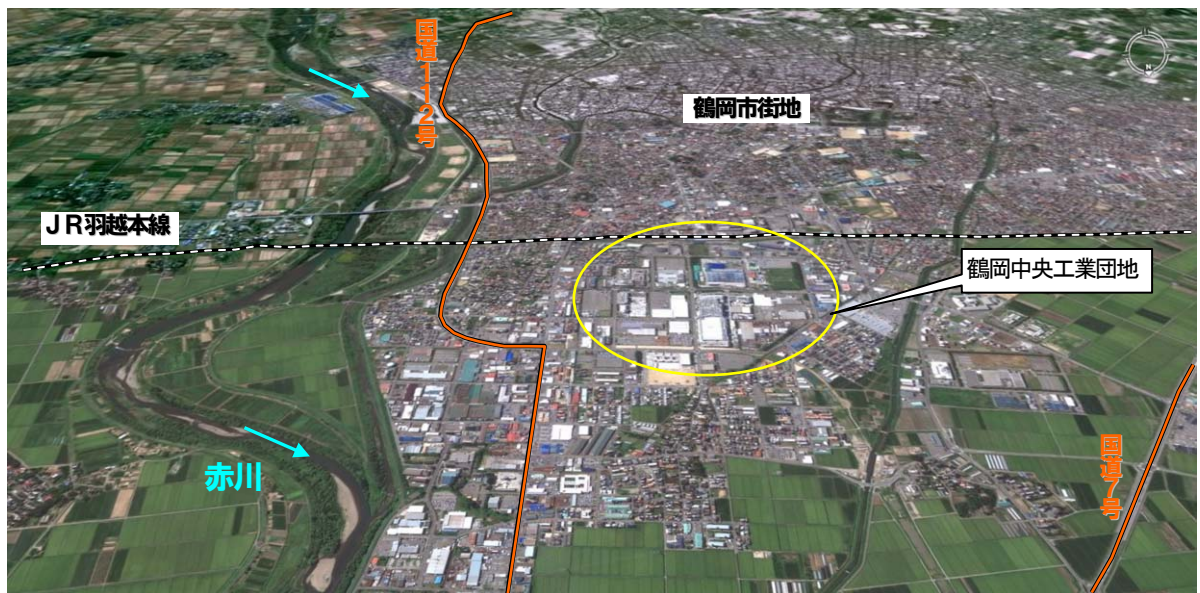
重要交通網JR羽越本線や国道7号、112号が整備され、山形県人口第2位の鶴岡市街地を流れる赤川 鶴岡市には、電子部品・デバイスの生産工場を有する鶴岡中央工業団地も存在する
