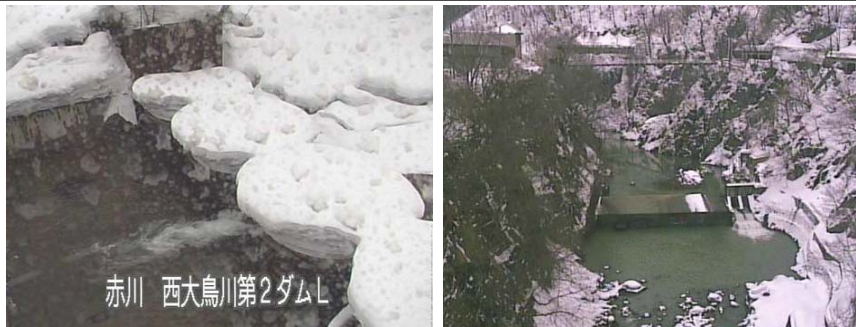
赤川 西大鳥川第2堰堤
