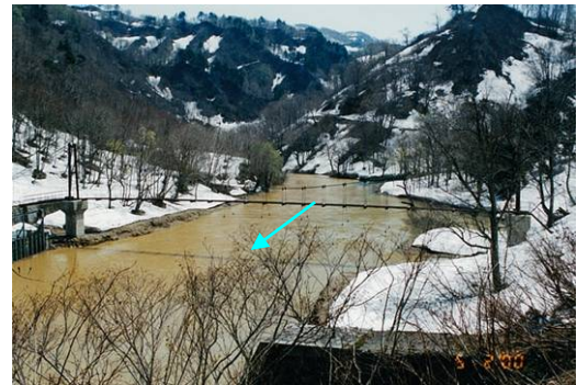
下流における濁水発生状況
